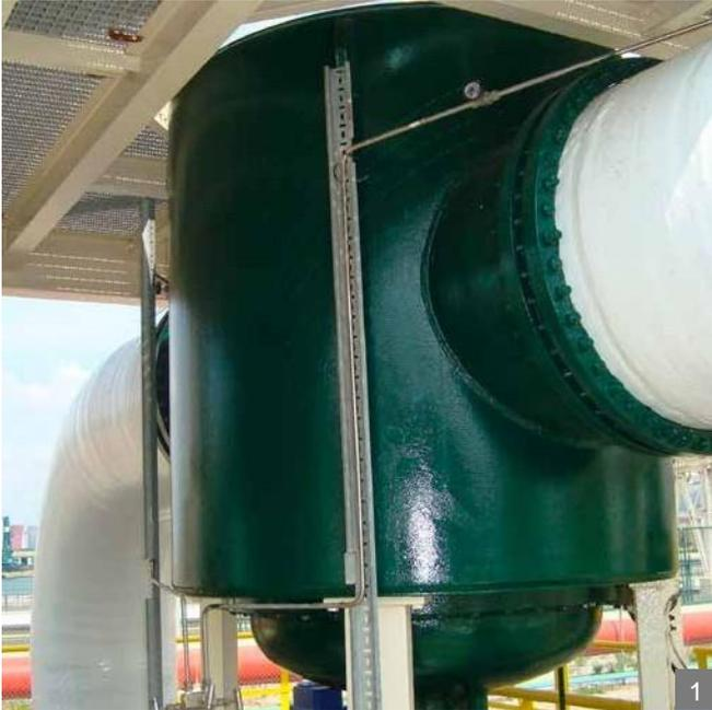
MetaLine® 785 – polimerna, gumolika zaštitna obloga za korozivne i mehanički visoko opterećene metalne konstrukcije.
